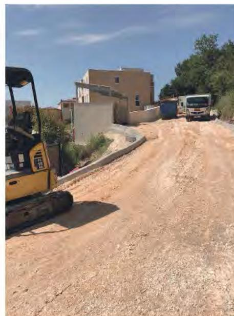
Entre temps l'entreprise de BTP a réalisé l'accès aux logements avec la pose d'une couche de maintien, des bordures pour les trottoirs et ensuite la pose de l'enrobé.
