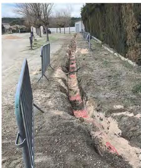
Après une demande de réalisation à Enedis pour la pose d'une borne fixe qui permettra un accès au réseau électrique, la commune via le syndicat de la voirie a fait installer les gaines électrique et les coffrets prises sur 2 endroits du terrain.
