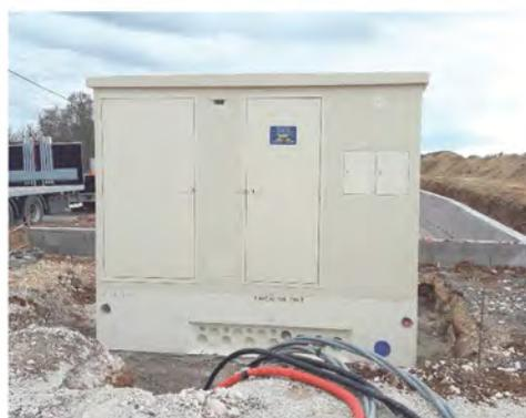
**Lotissement l'Oliveraie** : Après la pose du poste ENEDIS en février, celui-ci a été raccordé au réseau le 22 mars. Le lotissement est maintenant "sous tension". Le bassin de rétention est terminé, puisqu'il a été raccordé au réseau pluvial du lotissement, mais surtout la déverse vers le Teulon a été finalisée par la pose d'une buse de diamètre 800mm qui a été posée sous le tuyau de transport du gaz, dont un représentant a vérifié et validé le bon déroulement de cette opération délicate.
